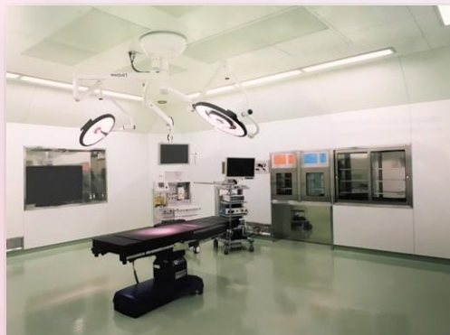
手術室(3室) (バイオクリーンルーム)
